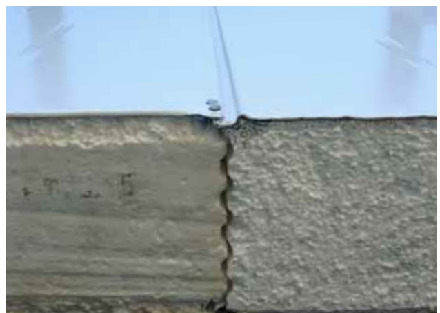
Unión machihembrada entre paneles.
