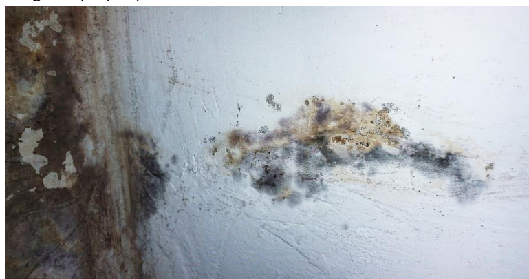
Fig 1 (arriba) Termograma e imagen real de diedro interior con humedad de condensación. (abajo) Moho creciendo en pared (Fuente: imágenes propias)
