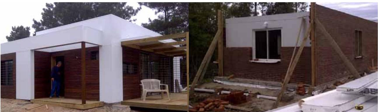
Este sistema admite otras terminaciones. Entre los revestimientos posibles (le llamamos revestimientos de paredes interiores o exteriores a materiales que se apliquen sobre los paneles y que tengan como fin cambiarle la textura de la ya determinada) están las pinturas, los revoques elastoplásticos, la aplicación de empapelados, la aplicación de revestimientos plásticos tipo "Cealing", materiales cementicios o mampuestos como ladrillos o piedra laja, teja (asfáltica o cerámica), etc.
