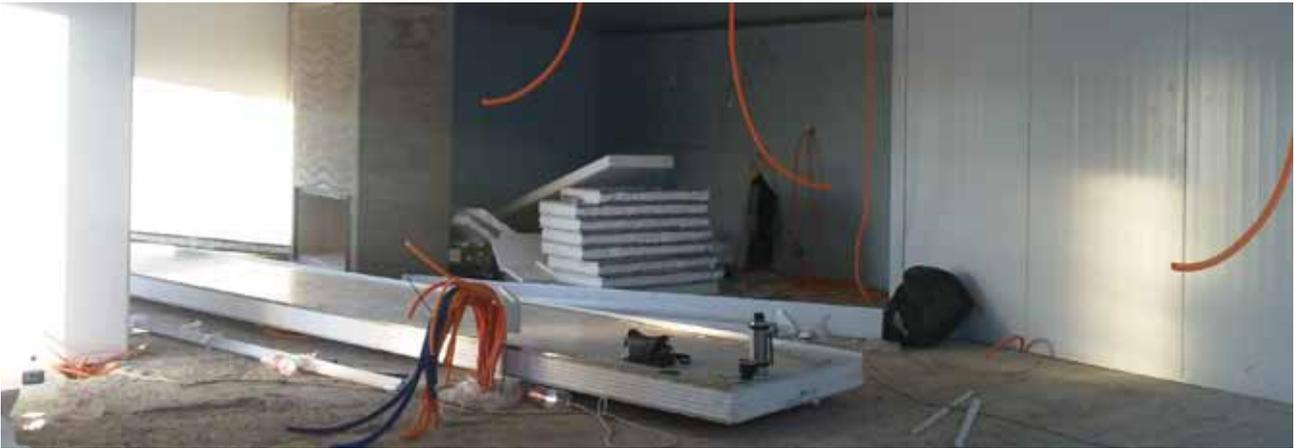
**f** | Una vez montados los paneles y las aberturas, se continúa con las terminaciones (colocación de accesorios como frontales, canalones, babetas, goteros, etc), y sellamiento exterior. Este último paso es muy importante, pues es el que garantiza la impermeabilidad de la construcción total.
