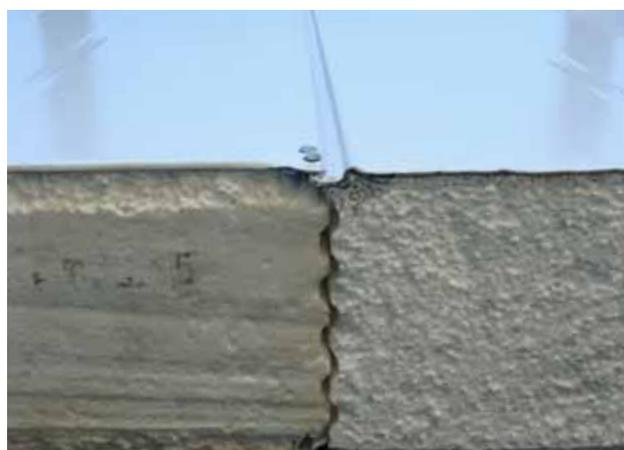
Unión machihembrada entre paneles.
