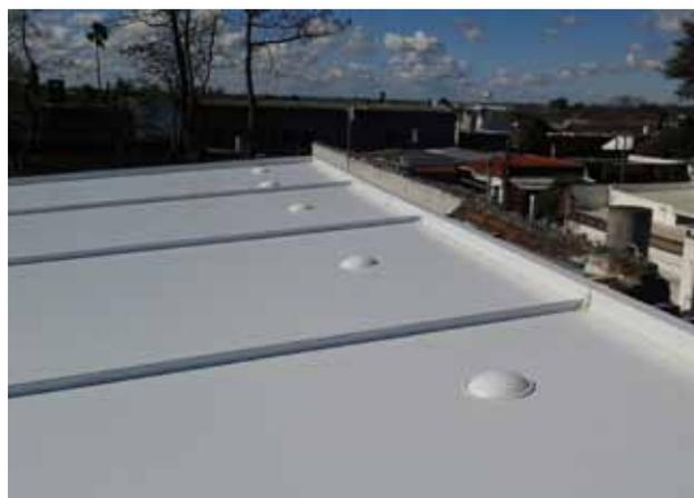
Anclaje pasante visto con tapa de polipropileno.
