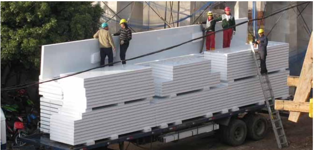
/ A efectos de evitar aplastamiento de dedos durante la formación de pilas de isopaneles, es necesario disponer de separadores de Espumaplast® entre las caras de los paneles.
