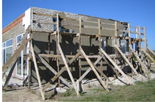
**machihembrado en ángulo**, para lograr un encastre perfecto. Posteriormente, el **pre-revoque para soportar la malla será colocado con llana dentada**; siendo necesario el refuerzo extra con el solape de la misma, en zonas como dinteles, antepechos o aristas. Finalmente, el **revoque de terminación puede ir colocado a rodillo o soplete, proyectado o con cuchara de albañil**.
