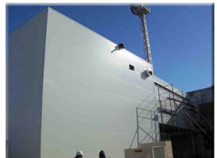
Otra forma de montar los paneles: apaisados, anclados a una estructura auxiliar
